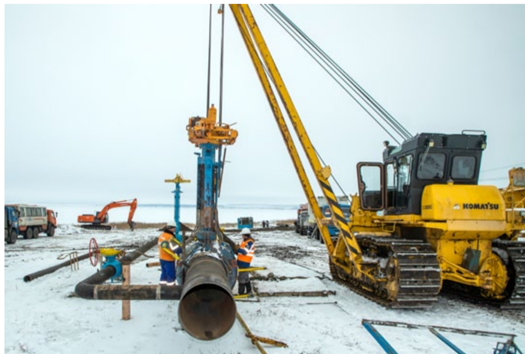
Процесс монтажа временного узла запуска очистных устройств и средств ВТД.
