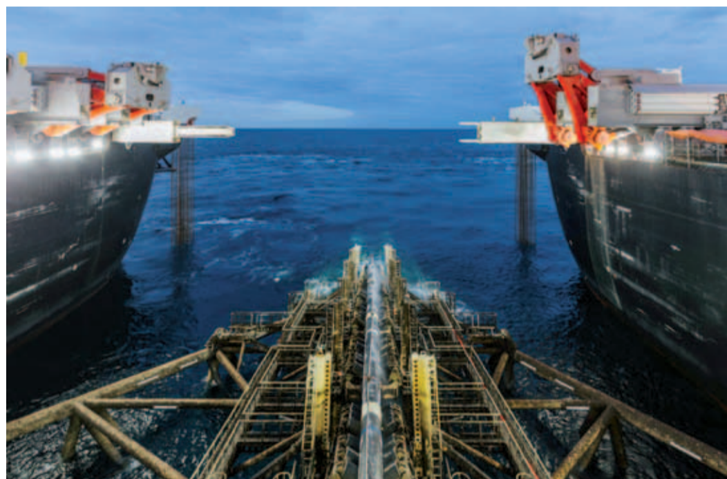
«Турецкий поток»: трубоукладчик «Пайониринг Спирит»
